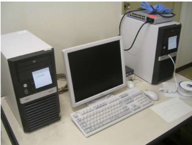
図4 新システムのサーバマシン
