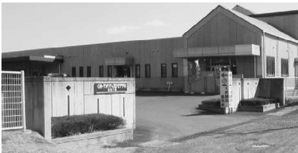
Fig.3 くめクオリティ・プロダクツ(株)高柿工場正門
