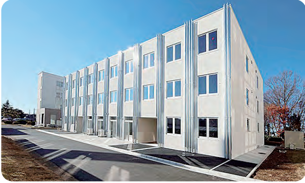
外観 External view
