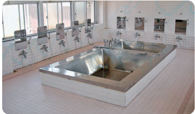
寮男子浴場 (管理棟) Bathhouse
