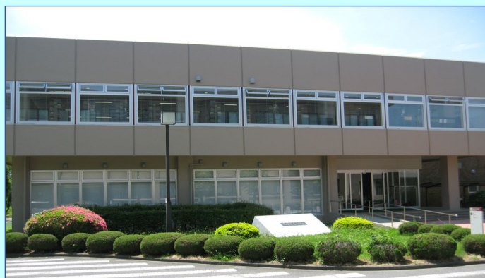
R3.3月改築後外観
